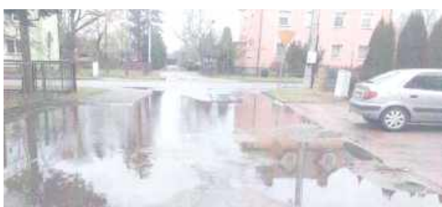
Po opadach deszczu stojąca woda nie pozwala na swobodne zaparkowanie i przemieszczanie się z dziećmi w kierunku przedszkola
