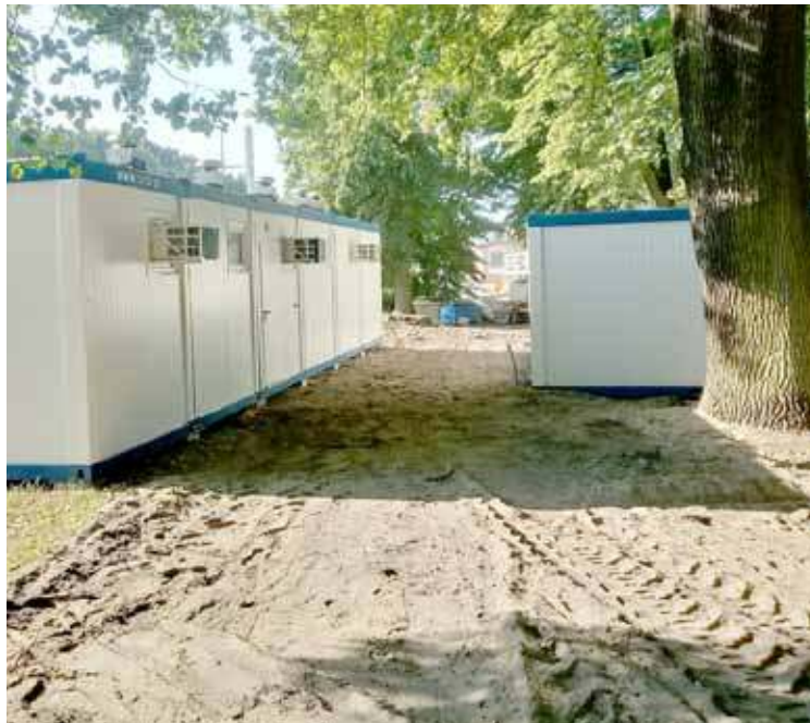
Kontenery, z których powstaje dworzec tymczasowy ustawiane są od kilku dni
