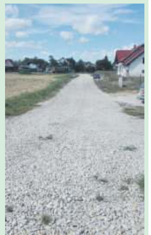
Gmina stara się o dofinansowanie między innymi na przebudowę ulicy Różanej i Makowej w Kondratowicach
