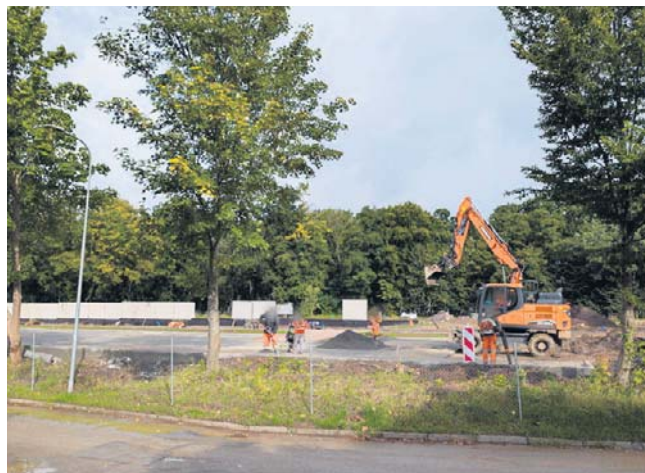
Prace przy rozbudowie Starego Cmentarza w Słupsku
