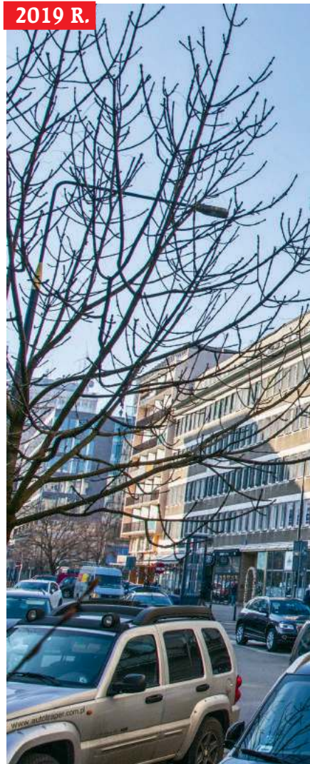
Żurawia 28 – wielkomiejską kamienicę zastąpiła ściana
