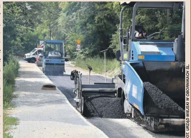
Kładzenie nawierzchni asfaltowej na ul. Paderewskiego w Obornikach Śl.
