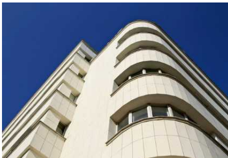
• Kamienica przy ulicy Świętojańskiej 68
