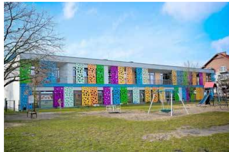
W nowej placówce będzie ponad 20 sal lekcyjnych – w tym pomieszczenia ze sprzętem komputerowym, a także do przeprowadzania doświadczeń fizycznych i chemicznych
