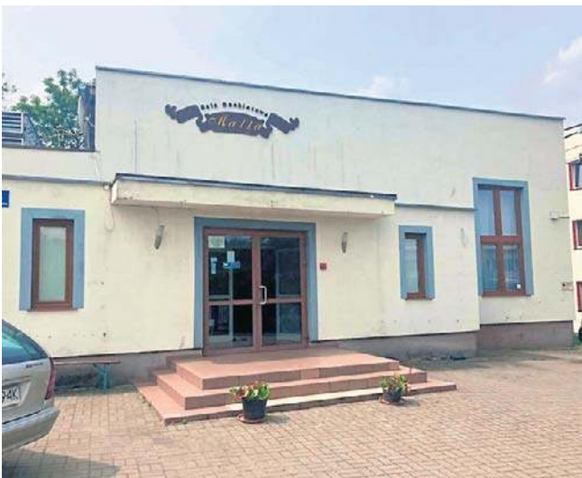
FOT. KRAJOWA RADA KOMORNICZA-SERWIS
