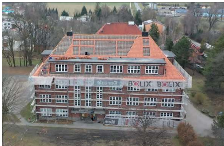
Remont dachu budynku II LO
