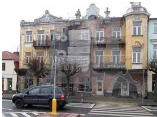
Obiekt wymaga szybkiego remontu
