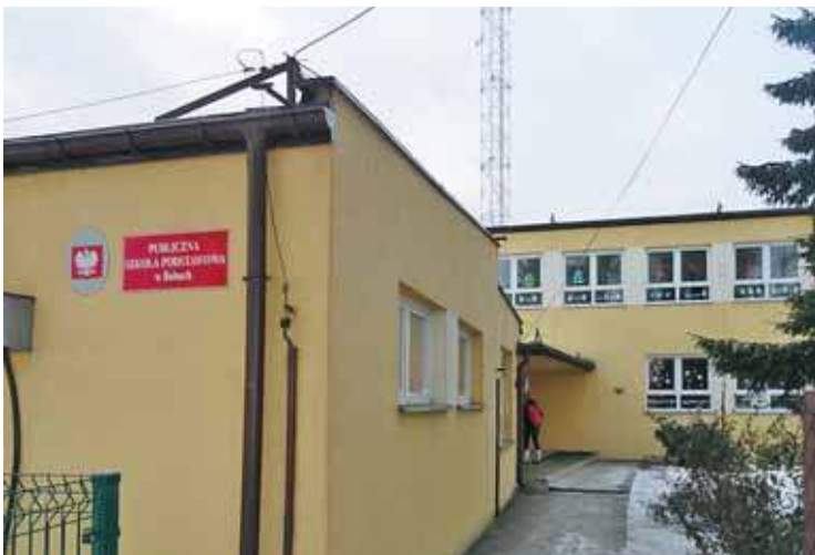
Punkt Przedszkolny powstał w budynku szkoły w Bobach (tu budynek przed termomodernizacją i przekształceniem szkoły)
