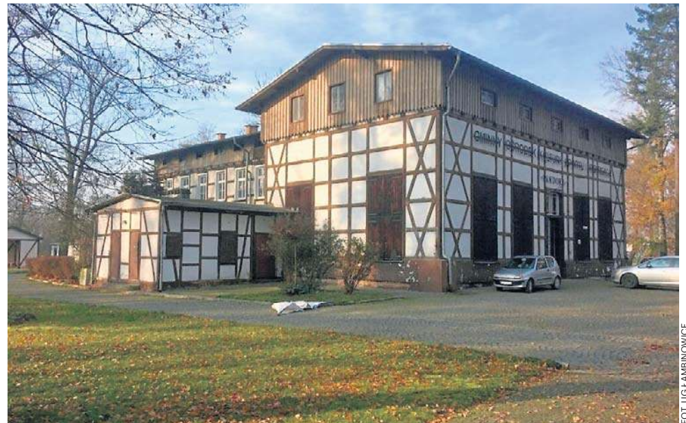
Władze gminy zamierzają przygotować dokumentację przebudowy głębokich piwnic pod „Pandorą” na miejsce zbiorowego schronienia dla ok. 200 osób.
