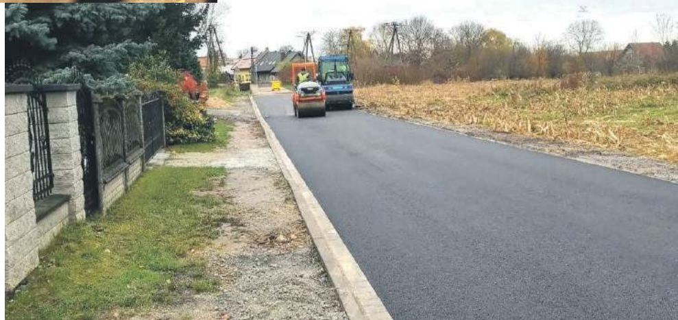
Przebudowa ostatniego fragmentu ul. Długiej w Szewcach
