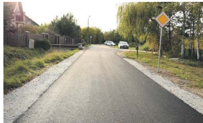
W Rogożu zakończono przebudowę ul. Topolowej
