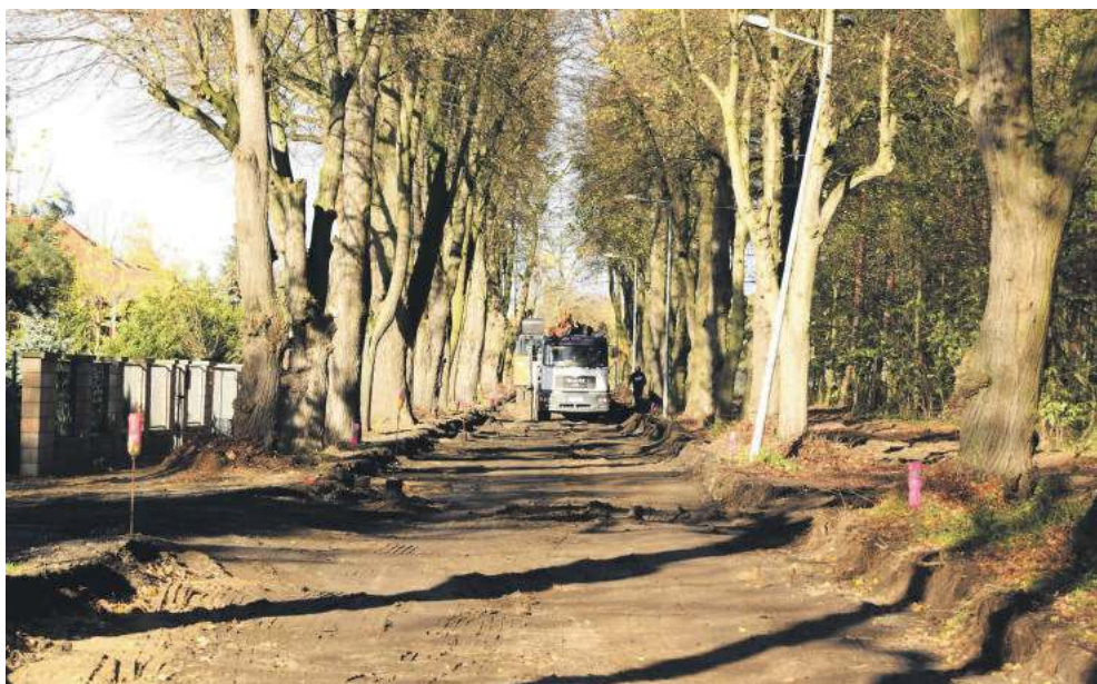
Rozpoczęła się przebudowa ul. Łąkowej w Wiszni Małej
