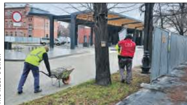
Dworzec nie jest już ogrodzony
