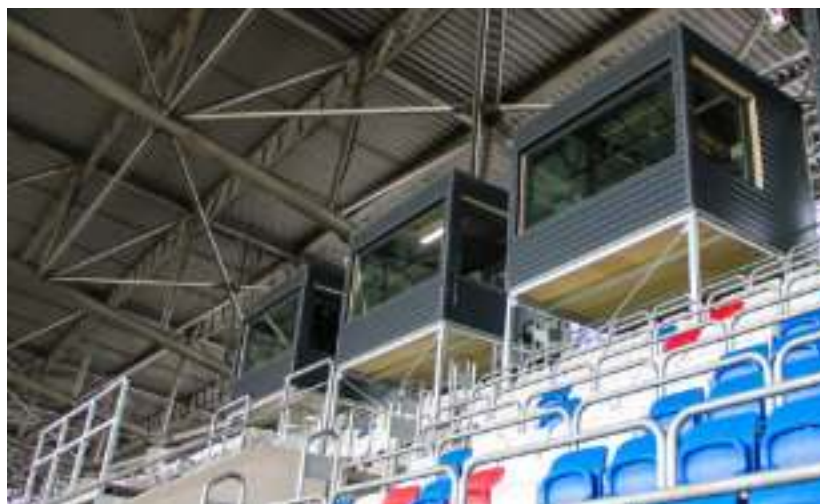
► Przygotowane w nowym miejscu kabiny komentatorskie Fot. Stadion w Zabrzu Sp. z o. o.
