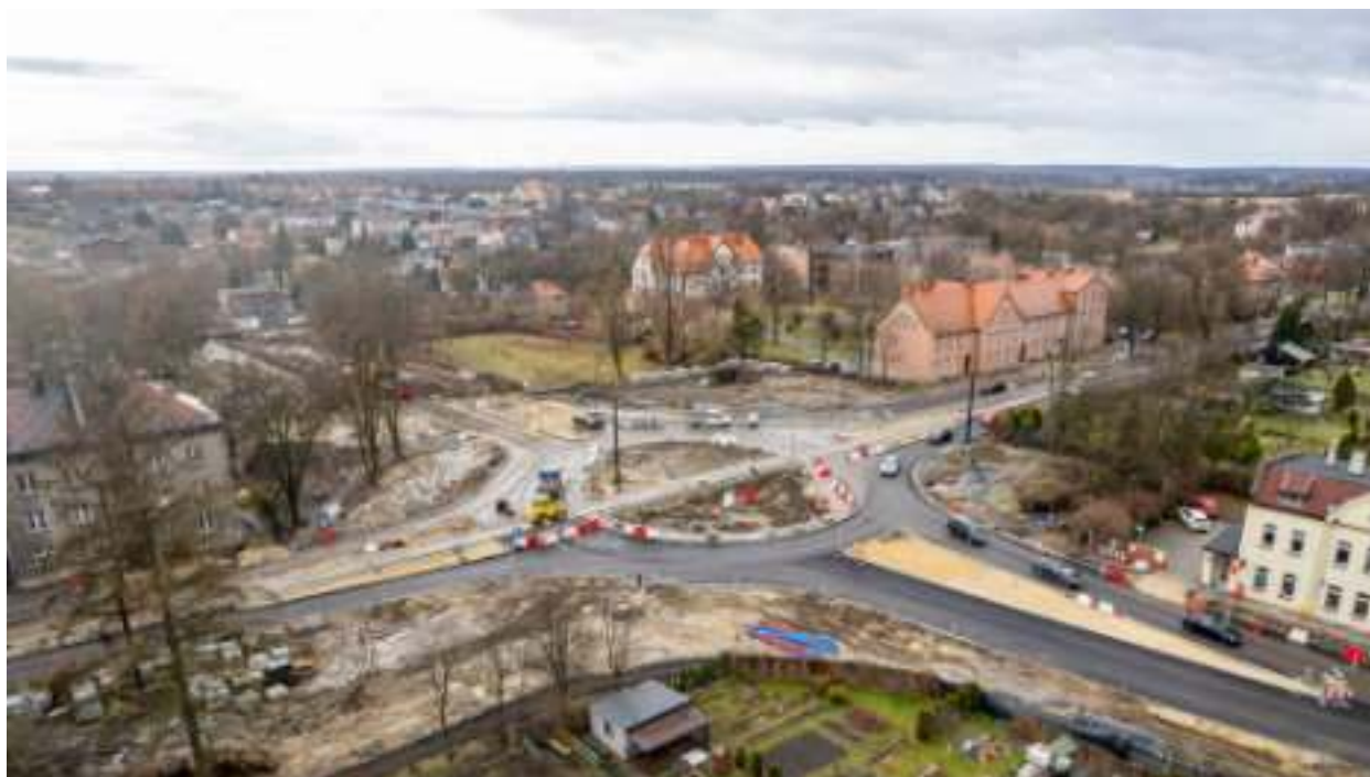
► Powstające w ramach inwestycji rondo Fot. UM Zabrze
