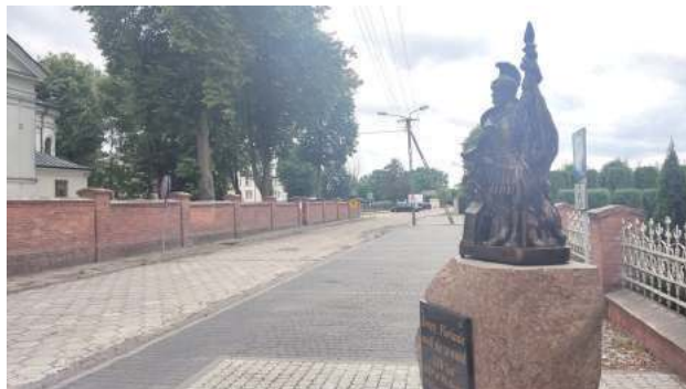
Strażacka w Wohyniu. Pracy jest tu sporo, bo m.in. planowane jest wykonanie podbudowy z tłucznia kamiennego, nawierzchni z szarej betonowej kostki brukowej o wysokości 8 cm na podsypce cementowo-piaskowej, zjazdów na posesze z kostki grafitowej itp.
