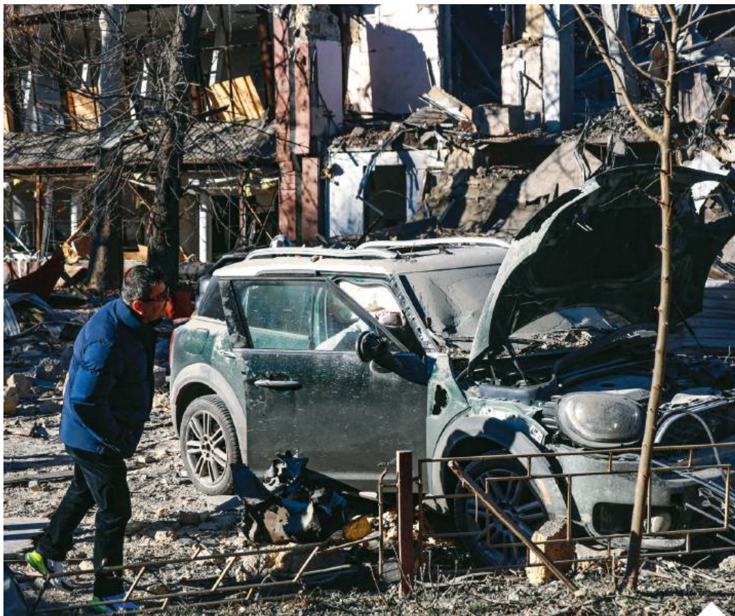
Przed zbliżającą się zimą głównym celem ataków rosyjskiego agresora nadal pozostają budynki cywilne oraz infrastruktura energetyczna | fot. Nina Liashonok/Reuters/Forum
