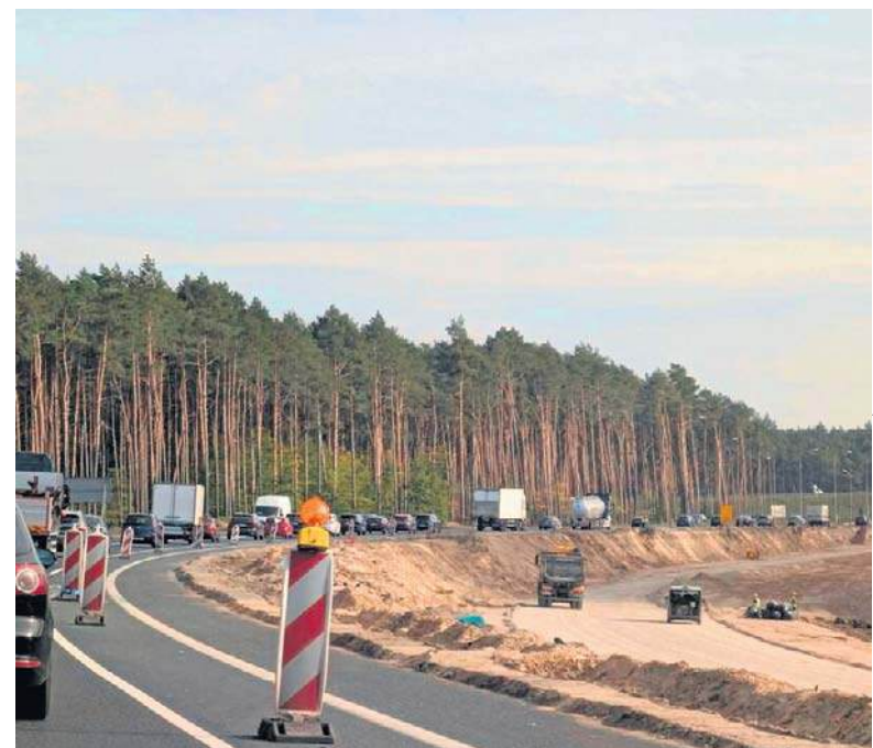
Budowa fragmentu trasy ekspresowej S10 na wysokości Torunia. Na zdjęciu budowa w rejonie węzła Toruń Zachód
