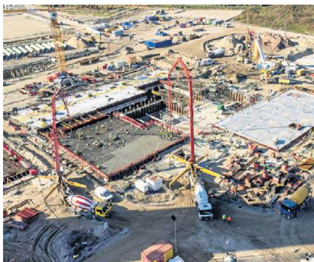
Prace fundamentowe na budowie elektrowni w Gdańsku
