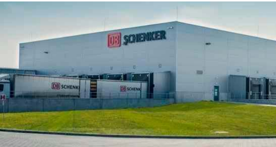
W SAG działa już terminal logistyczny firmy DB Schenker
