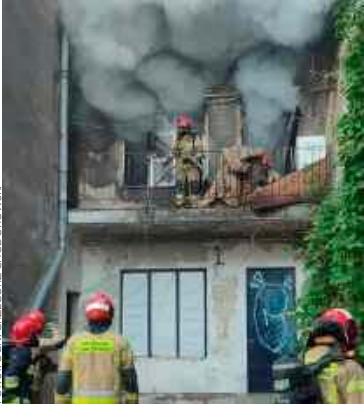
Pożar w kamienicy przy ul. Królewskiej gasiły trzy zastępy straży pożarnej
