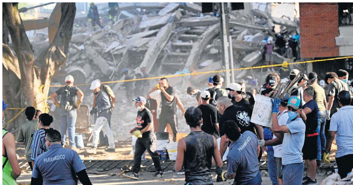
Wolontariusze i ratownicy szukają ocalałych w gruzach zawalonego budynku po trzęsieniu ziemi w Cali
