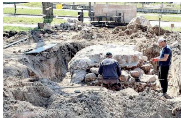
... a tak wygląda teraz. Monument został zdemontowany i wykonywane są pod nim żelbetowe fundamenty
