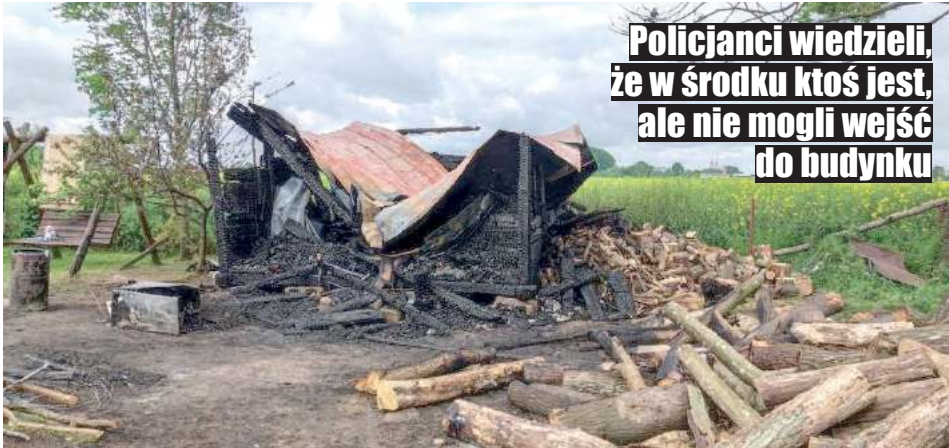
Doszczętnie spalił się drewniany budynek w miejscowości Gęś w gminie Jabłoń
