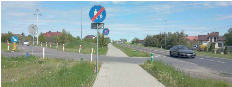
W tym miejscu obecnie jest zjazd z ul. Radzyńskiej na tzw. Małą Obwodnicę Łukowa. Już wkrótce powstanie tu rondo za 5 mln zł
