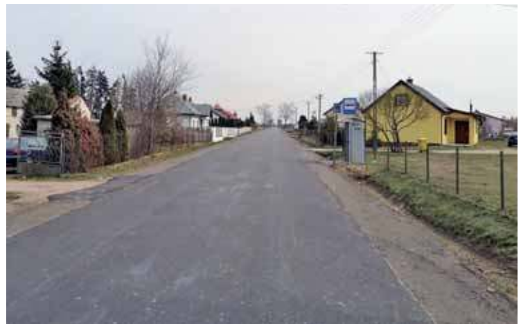
Fragment zmodernizowanej drogi
