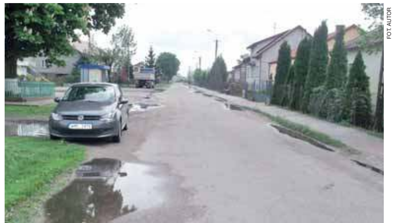
Droga przez Kowalewo przed modernizacją
