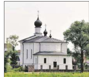
Parafia pw. św. Apostoła Jana Teologa otrzymała dotację na renowację ok. 600 m2 polichromii na ścianach
