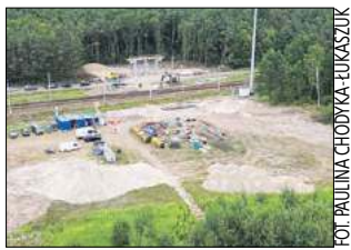
Budowa wiaduktu już trwa, zakończyć ma się w 2025 roku
