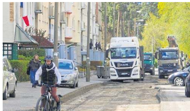
Remont odcinka ulicy Krasieńskiego rozpoczął się od sfrezowania starej nawierzchni jezdni
