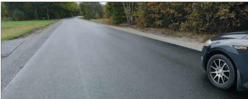
Nowo odremontowana nawierzchnia w Płazówce.
