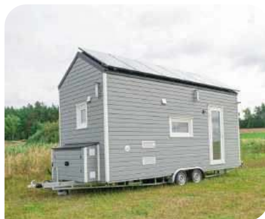
Jedną połać dachową zajmują solarzy; domek można ustawić, by miał właściwą ekspozycję na słońce
