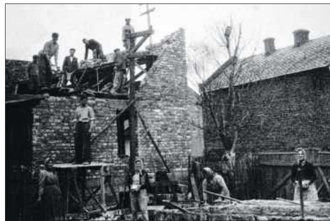
■ Budowa domu Szafarczyków przy ulicy Rostka. Przy budowie pracuje cała rodzina.
