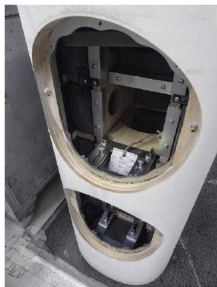
Stalowe elementy przedłużają łączą szkielet z przednią ścianką, także wzmocnioną warstwą aluminium.
