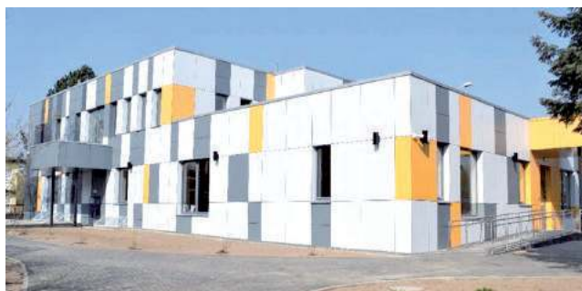
To właśnie w tym budynku przy ul. Kołłątaja w Puławach działa wypożyczalnia sprzętu rehabilitacyjnego
