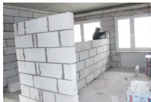
W całym obiekcie wymieniono okna, a dzięki podniesieniu ostatniego piętra budynku w górę i likwidacji skosów kondygnacja stanie się bardziej funkcjonalna. Obecnie na tym poziomie powstają nowe ścianki działowe
