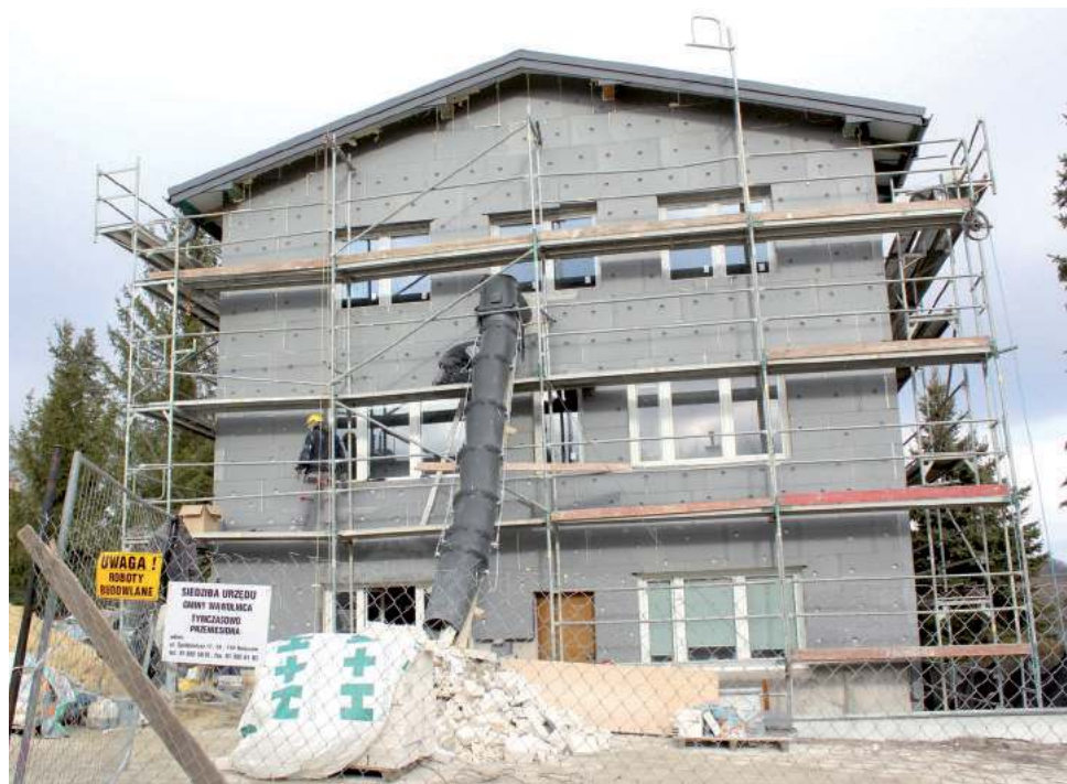
Budynek Urzędu Gminy w Wąwolnicy jest w trakcie termomodernizacji. Budowlancy ocieplili obiekt styropianem i wkrótce przejdą do kolejnego etapu prac
