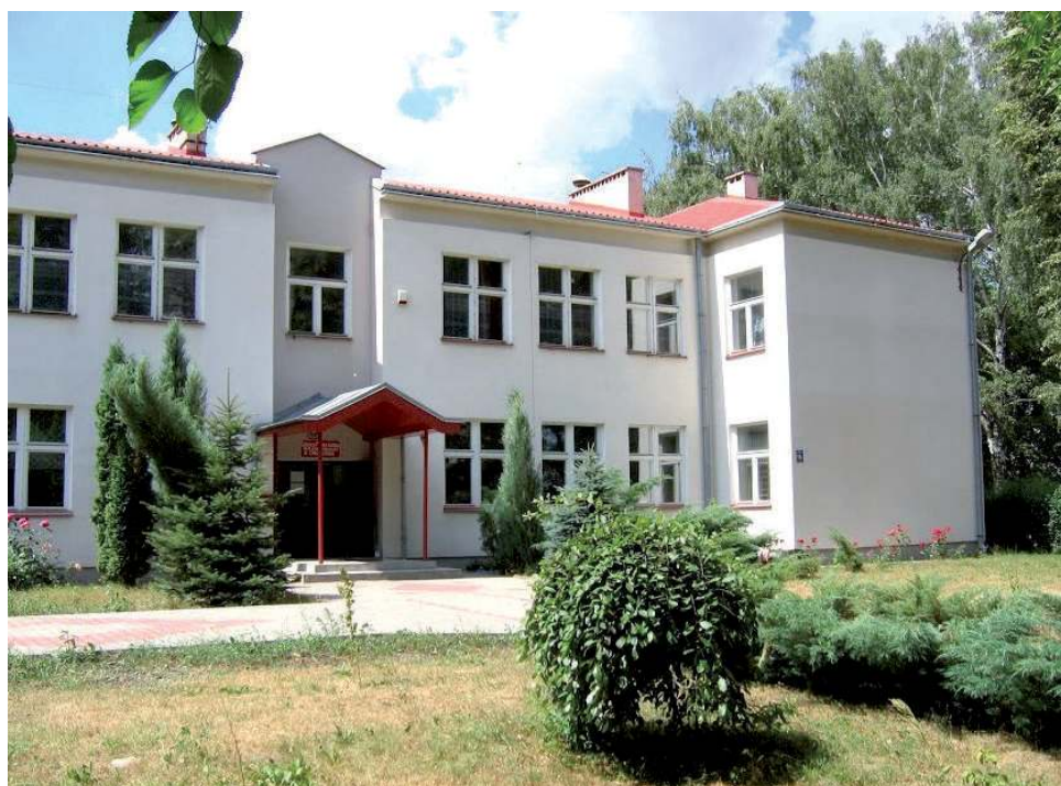
Już niedługo Szkoła Podstawowa w Chrzążachowie przejdzie gruntowną termomodernizację
