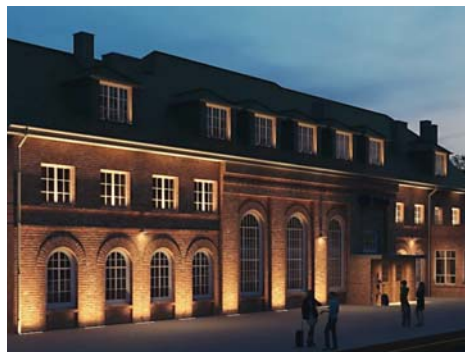
Rozpoczyna się modernizacja dworca w Pasłęku 3
