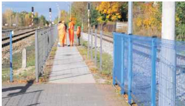
Ekipa rozbierająca przejście pojawiła się 28 października
