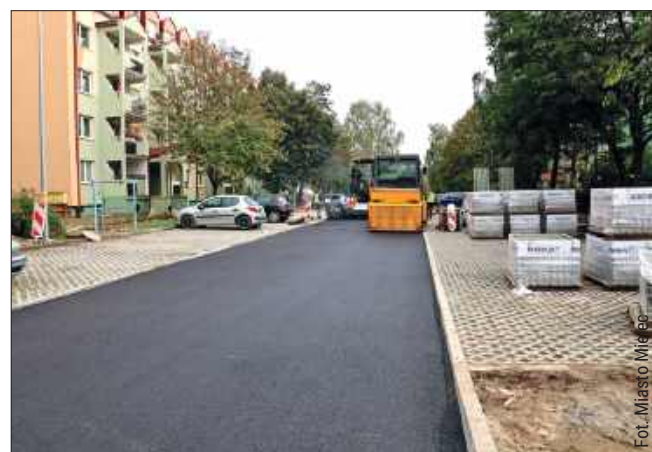
Trwające prace na Warneńczyku
