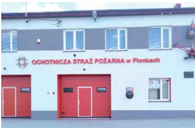
Defibrylator AED zawieszony na remizie OSP w Płonkach
