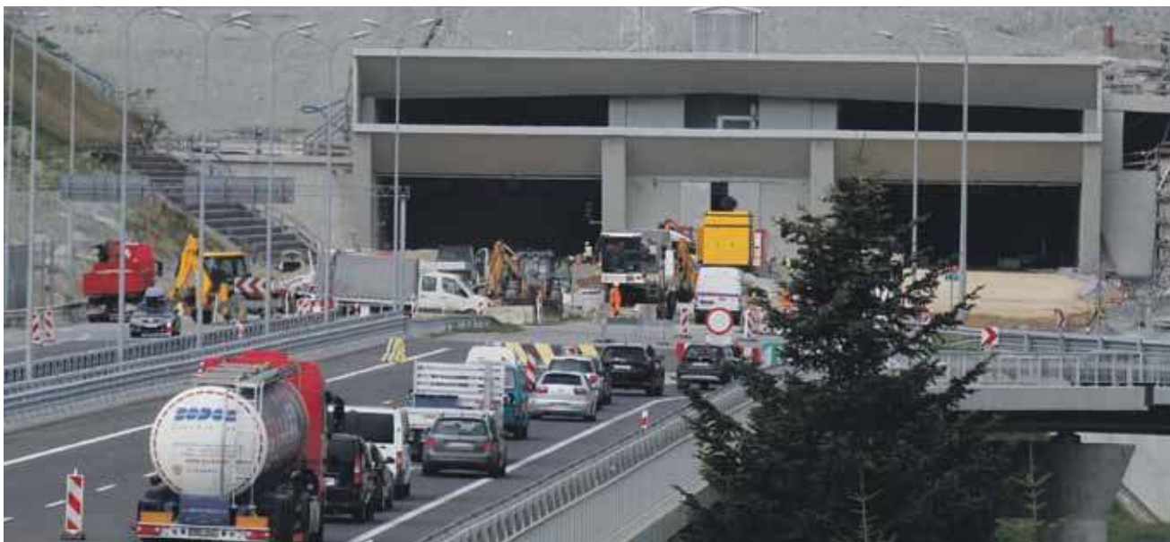
Południowy wlot do tunelu pod Małym Luboniem.
