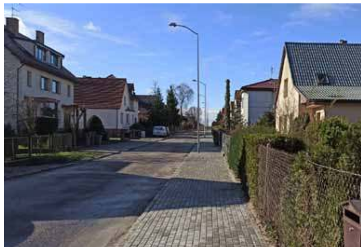
Na ulicy Szymanowskiego wykonano nowy chodnik z kostki betonowej
