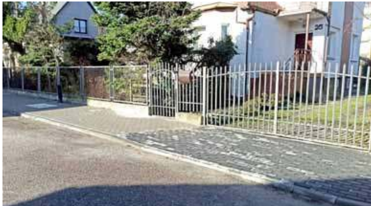
Mieszkańcy zyskali również wyremontowane wjazdy przy posesjach
