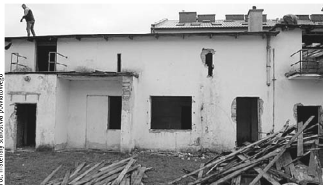
Tak wyglądał początek prac rozbiórkowych
