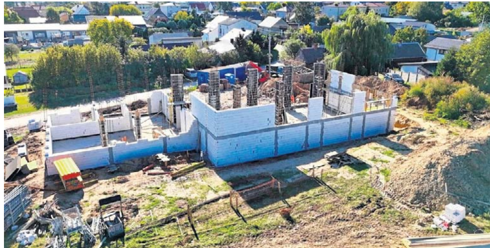
Nowa strażnica Ochotniczej Straży Pożarnej w Ciepeliowie pnie się w górę. Budowa kosztuje niemal 4,5 miliona złotych.
