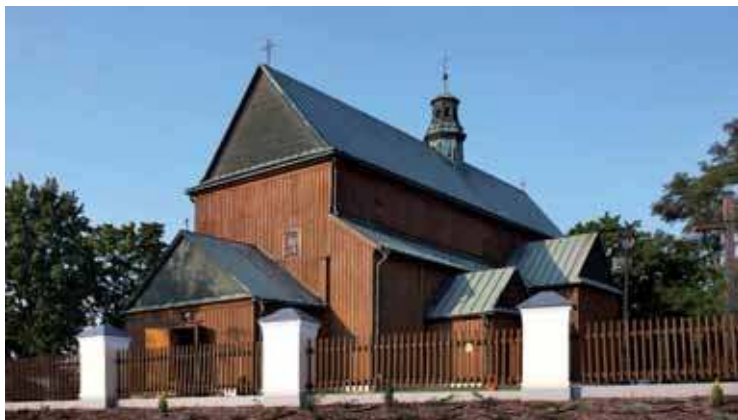
Osiemnastowieczny drewniany kościół Wszystkich Świętych w Dąbrowie Tarnowskiej
