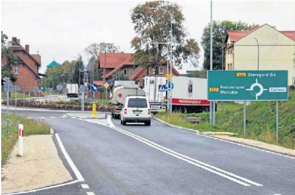
To kolejny etap budowy połączenia prowadzącego w kierunku autostrady A1
