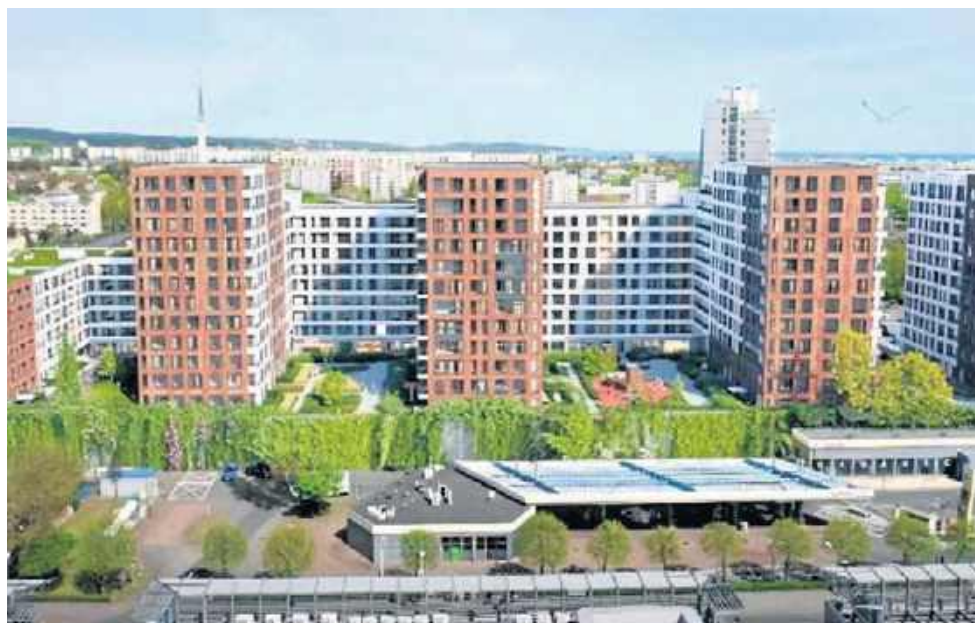
Taki monstrualny blok powstanie po wyburzeniu Alfa Centrum
