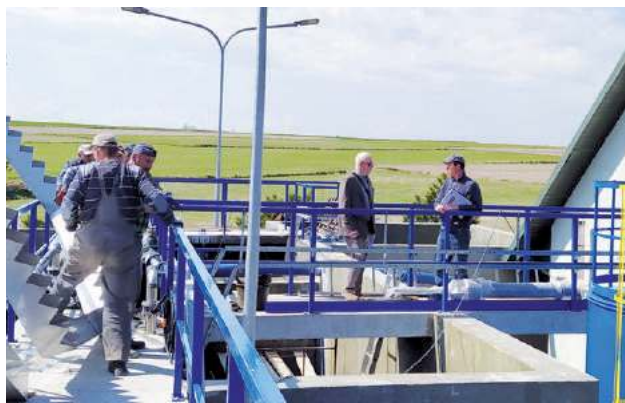
Rozbudowa oczyszczalni ścieków.
