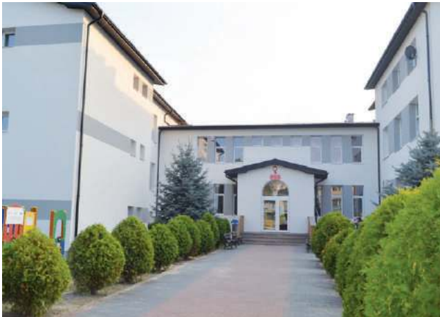
Termomodernizacją objęto wszystkie szkoły z terenu Gminy
