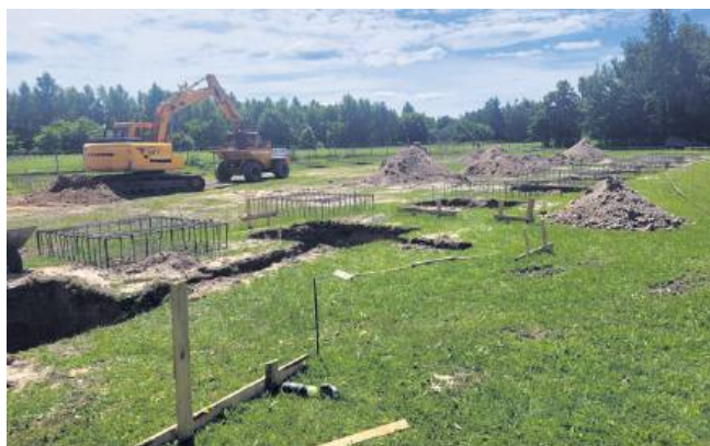
Na terenie gm. Tomaszów powstaje czwarta sala gimnastyczna.
