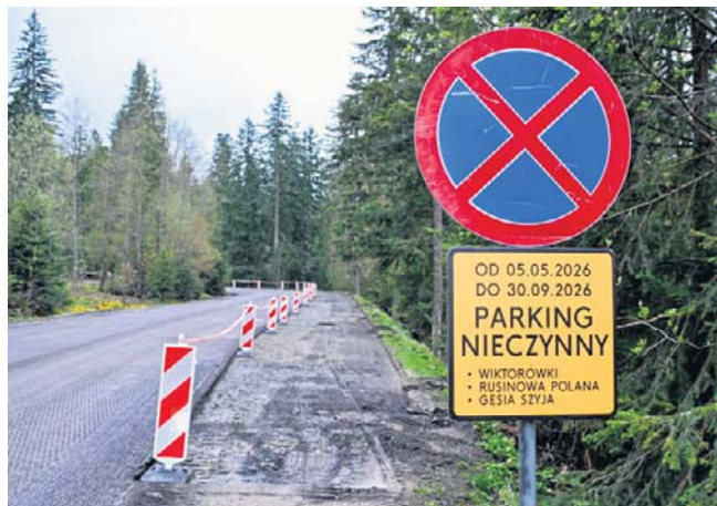
Zamknięty parking na remontowanej drodze Oswalda Balzera
