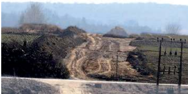
Pierwszy etap budowy obwodnicy Nałęczowa. Obwodnica ma uwolnić miasto od nadmiernego ruchu pojazdów, zwłaszcza ciężarowych, a tym samym pozwoli mu zachować status uzdrowiska
