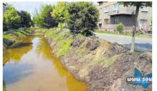
Kozi Bród, rok 2026 – muł wydobyty z rzeki w trakcie prac
