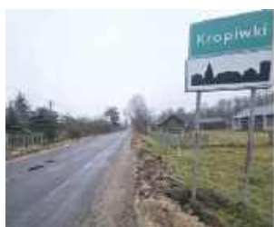
Prace już trwają, droga zostanie poszerzona
