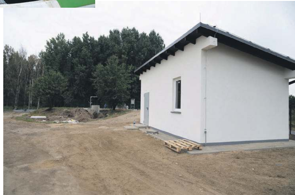
Modernizacja oczyszczalni ścieków w Brzeźnie na finiszu
