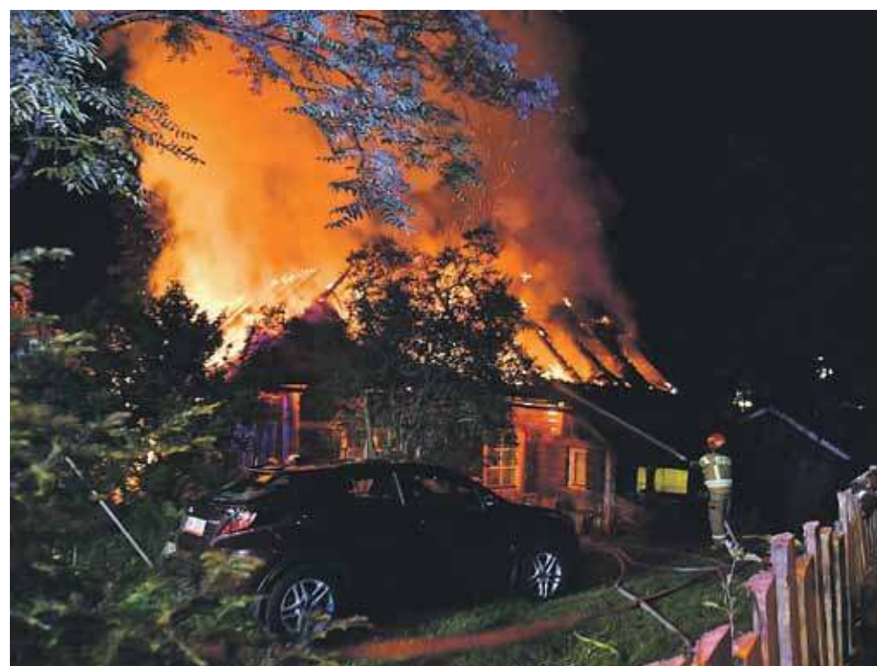
Gdy strażacy przybyli na miejsce, cały budynek stał w ogniu.
