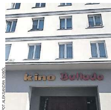
Budynek Ballady poddany zostanie gruntownej modernizacji
