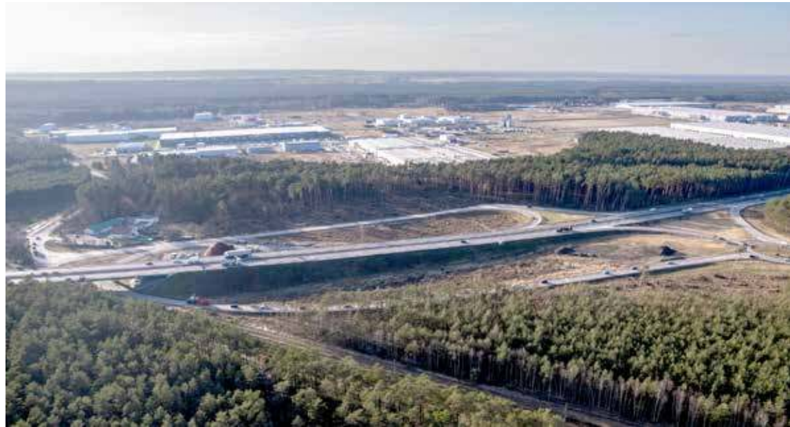
Zdjęcie z powietrza węzła Goleniów Południe
