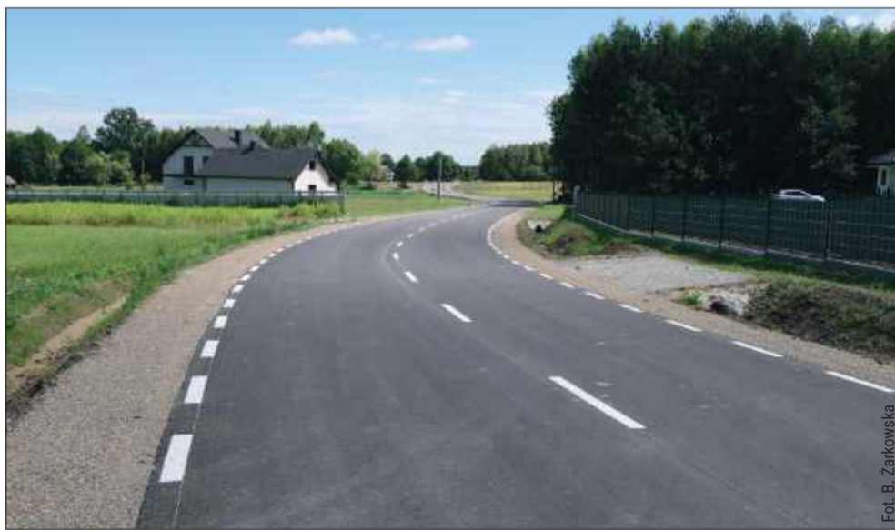
Nowo przebudowana droga powiatowa Kłapówka – Pogwizdów – Hucisko.
