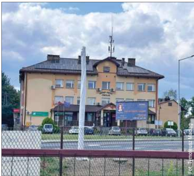
Aktualnie trwa montaż nowego urządzenia rejestrującego prędkość.
